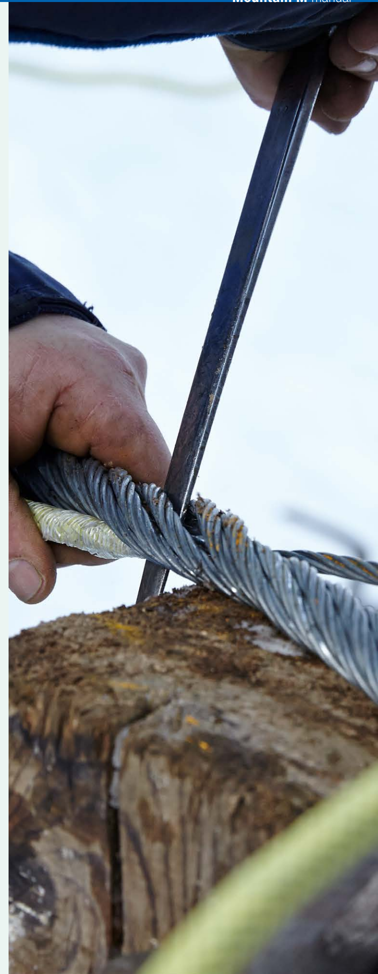
Spleissarbeiten am Litzenseil – dies kann auch Reparaturzwecken dienen
